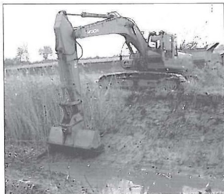
Hanyi-főcsatorna kotrása a Hanyi projekt keretében
