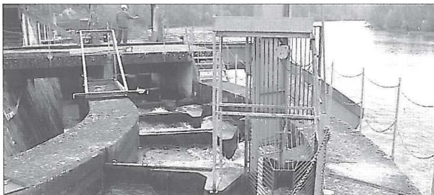
Réselt halátjáró az erőtelep mellett
