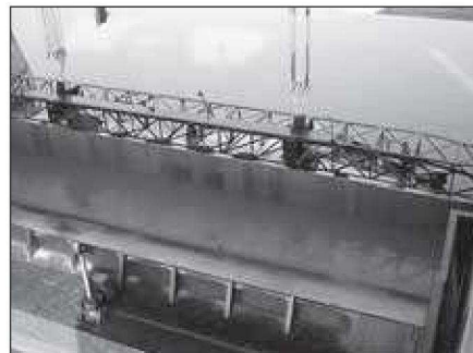
Felvízi ideiglenes elzárótábla kiemelése
