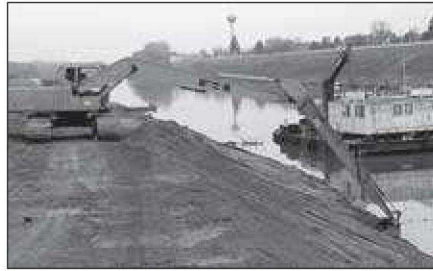
A mederrézsű helyreállítása
