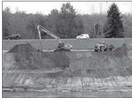
A tervezett rézsű kialakítása
