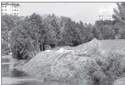
A megcsúszott rézsű a felrakódott hordalék eltávolítása után
