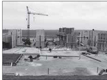
A Tiszaroffi árvízi tározó északi műtárgya
