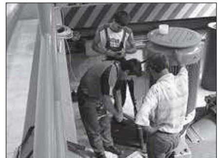
Kanyari szivattyútelep kábeleinek pótlása
