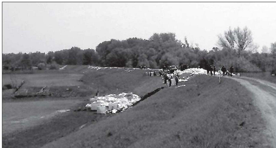
A Körös-zugi töltések fejlesztése elengedhetetlen, hogy ilyen eseményekkel ne kelljen szembe nézniünk a térségben. A kép a Mesterszállás mellett történt rézsúcsúszás helyén készült.
