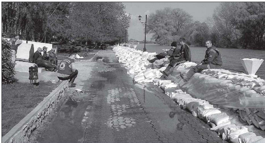
A Tiszaparti sétányon lévő régi, árvízvédelmi szempontból nem megfelelő parapetfal helyett biztonságos árvízvédelmi mű épül
