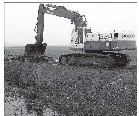
A 33-as belvíz-főcsatorna kotrása
