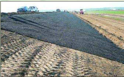
Tiszaroffi szükségátározó, vízoldali rézszű kiépítés
