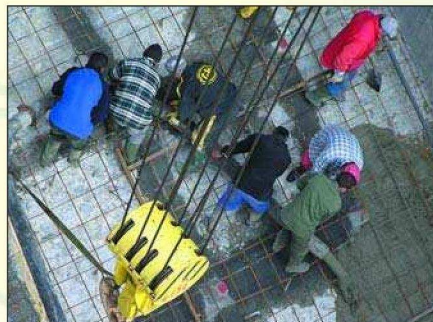
Kopóbeton készítés
