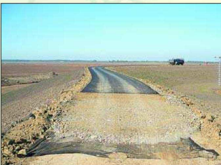
Kerékpárút építése a tározó töltésakoránál
