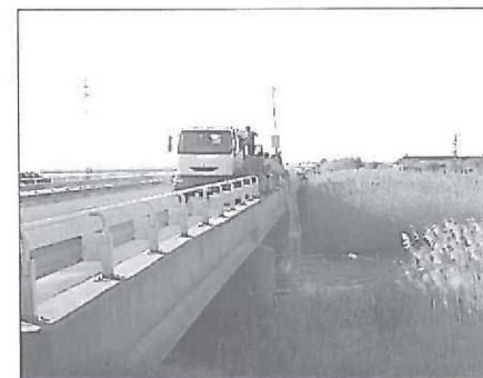
Nagykunsági-főcsatorna szenttamási híd
