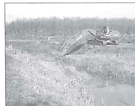
Kakat-főcsatorna rézsűbecsúszás helyreállítása
