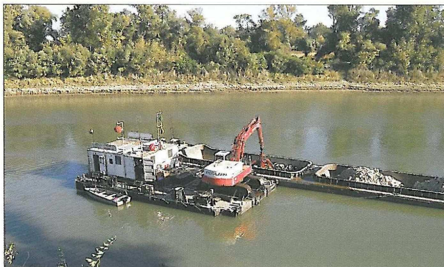
Árvízi helyreállítási munkák
