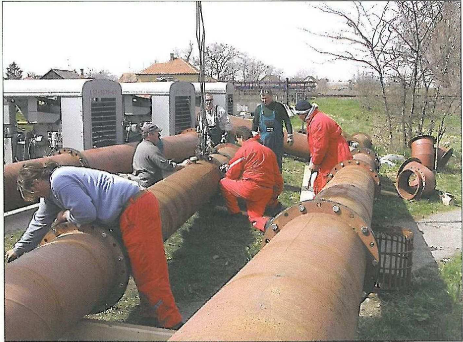
Szivattyúszerelés a Közös-főcsatornán a tavaszi belvízvédekezés során
