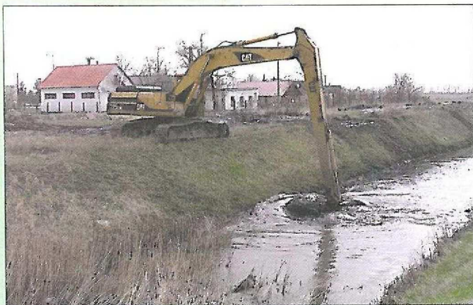
Karcagi I. belvízcsatorna kotrása
