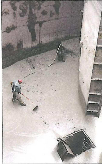
Hajózsilip víztelenítés után - munkaterület előkészítés
