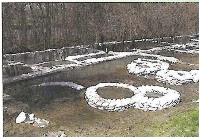
Ellennyomó medencék a Tisza j. milléri árvédelmi töltés mellett
