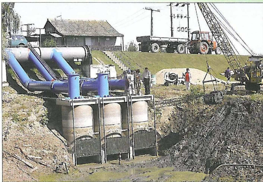
A Nagykunsági VGT üzemeltetésében lévő Gástyási vízkivétel átépítés közben
