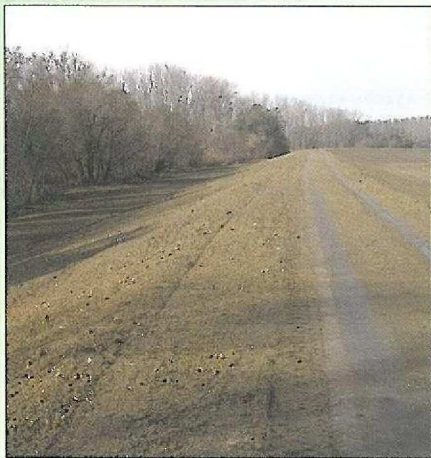
Műszaki átadás-átvétel - 10.08. szakasz
