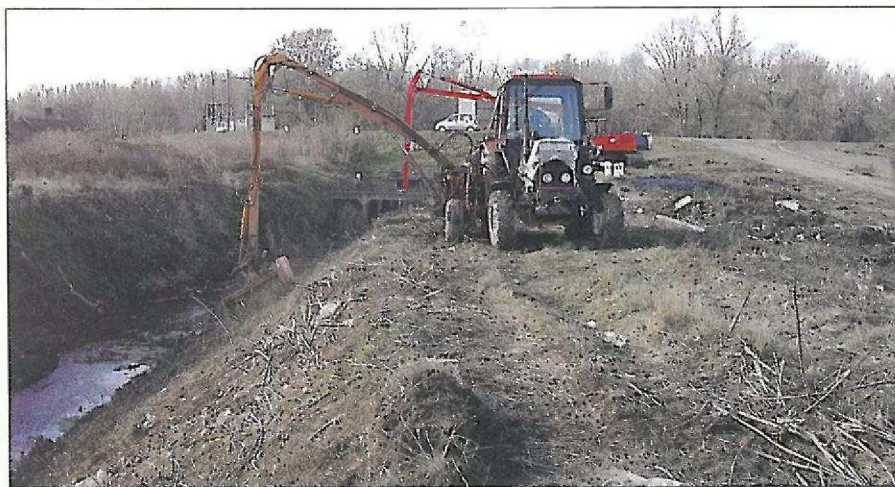
Gaztalanítás a Tiszabői-főcsatorna torkolatában
