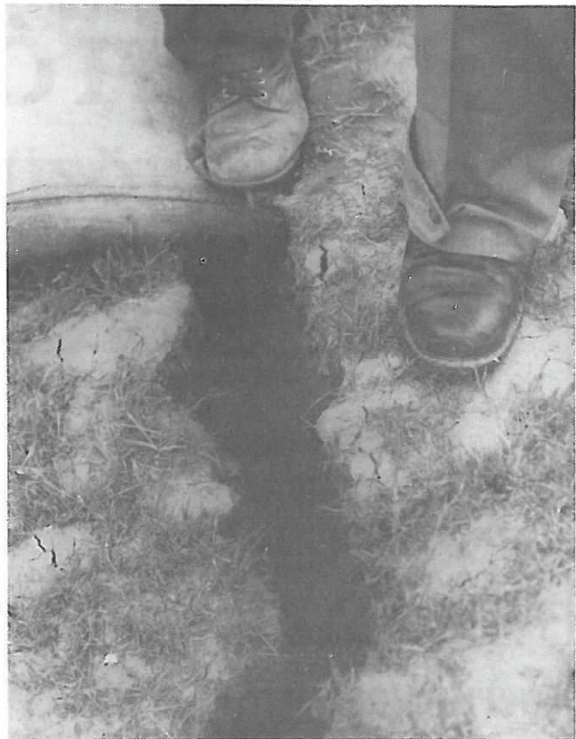
Tizsakürti töltésrepedés
